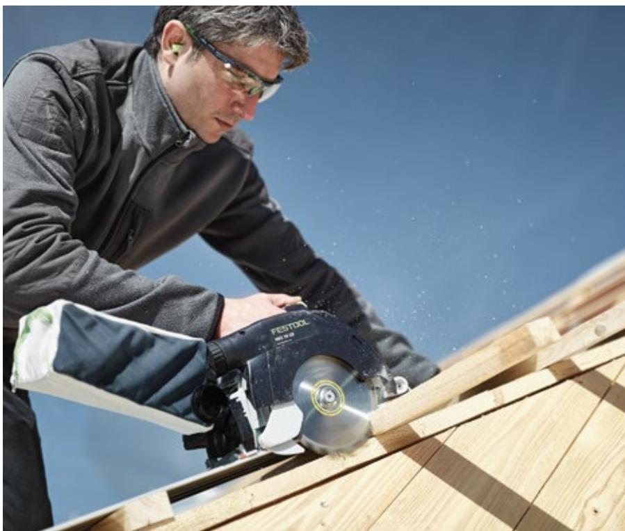
**Un guidage précis :** combinée au rail de guidage, la scie plongeante HKC 55 prouve sa polyvalence – idéale pour la découpe de lattes, de cadres et autres planches
