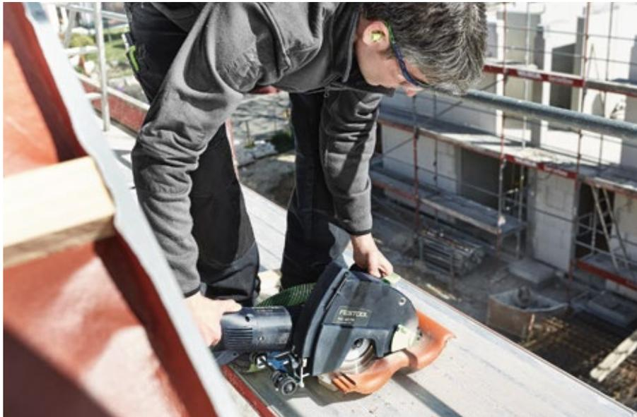
**Précision et propreté :** grâce au système de tronçonnage diamant DSC-AG 230, vous coupez les tuiles de manière rapide, précise et sans poussière.
